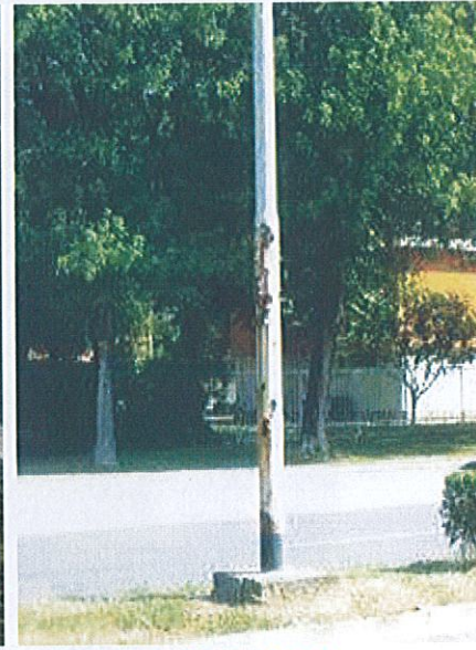
Sostegni con evidenti segni di ruggine in Via Primo Maggio
