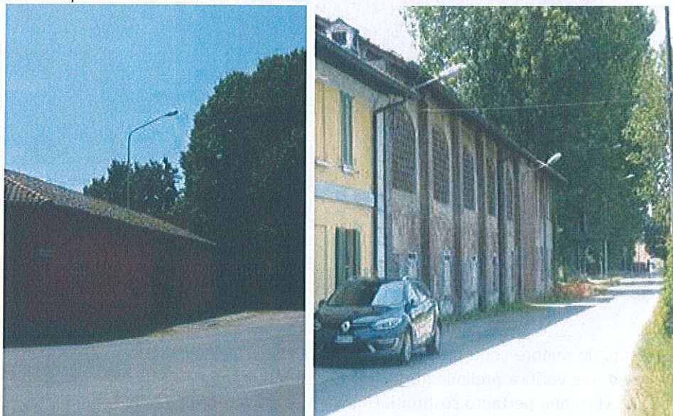
Punto luce con amarro su tetto e linea aerea in P.zza Mazzini (sx) – linea aerea Via S. Carlo (dx)
