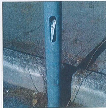
Protezione all'incastro mancante (sx) – copertura mancante (dx)
