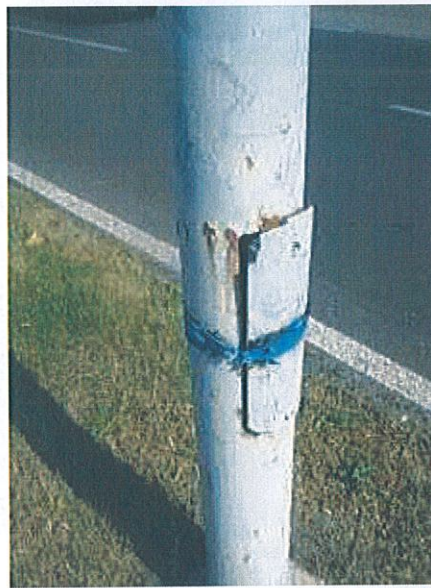
Sostegni con evidenti segni di ruggine in Via Primo Maggio
