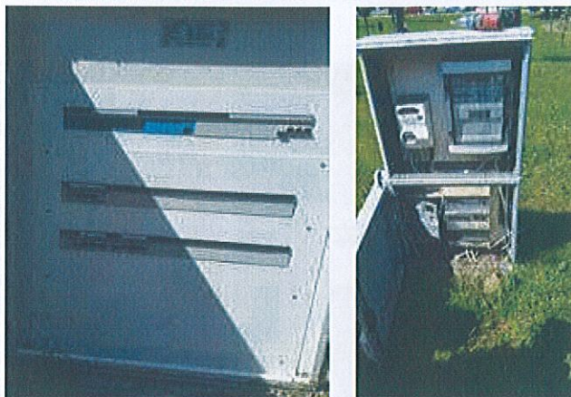
QE COMUNALE – Via Bellaria (sx) – Via dalla Chiesa (dx)
